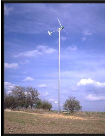
Aerogenerador de 10 kW
