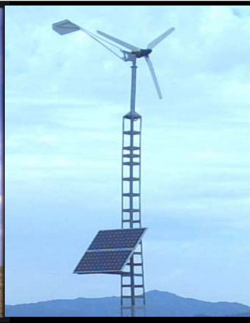
Aerogenerador de 1.4 kW
